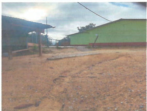
Foto 3: Losa de Patio
