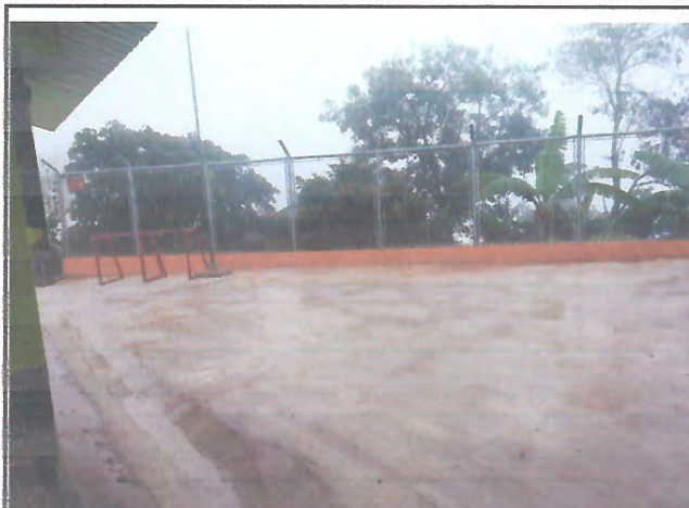
Foto 2: Estructura de Techo tipo Pórtico en área de patio
