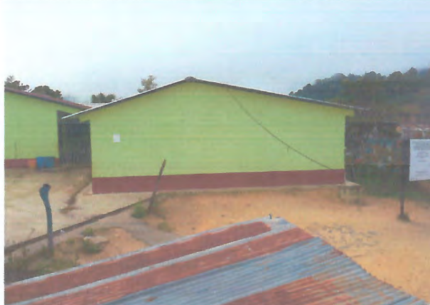
Foto 4: Losa de Patio
