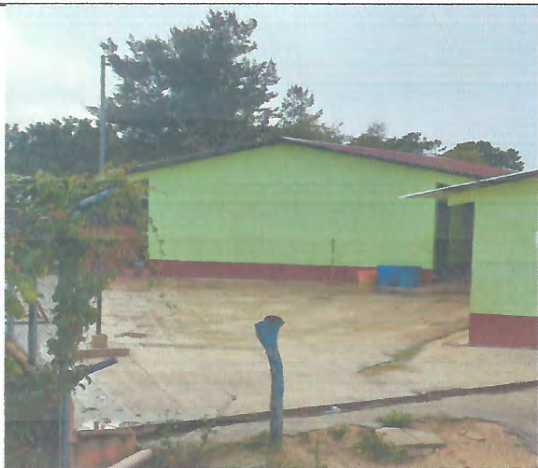
Foto 1: Estructura de Techo tipo Pórtico en área de patio
